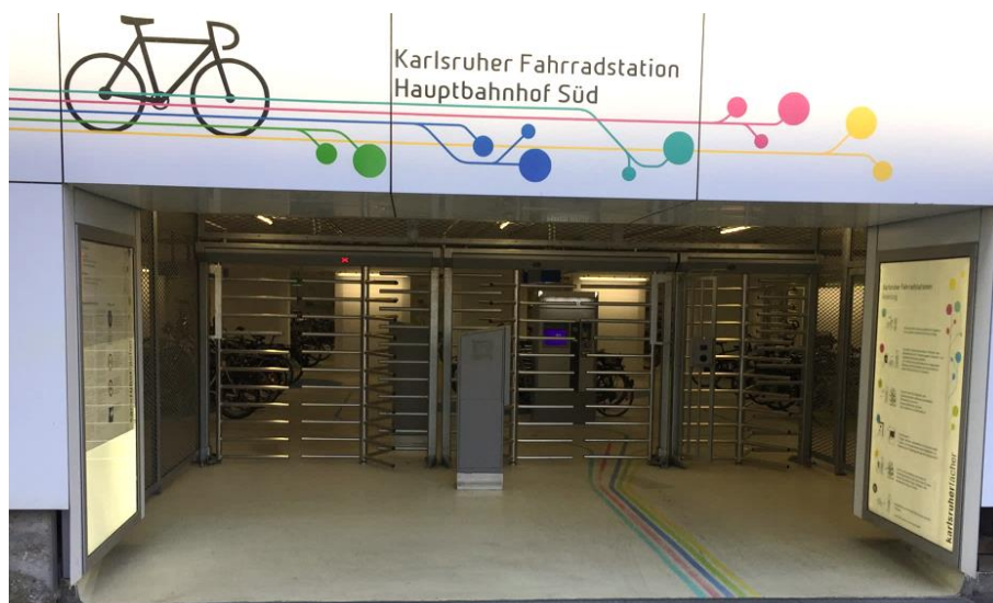
Abbildung 56: Beispiel Mobilitätspunkt - Karlsruher Fahrradstation Hauptbahnhof Süd (eigenes Foto (VAR+, 2021))
