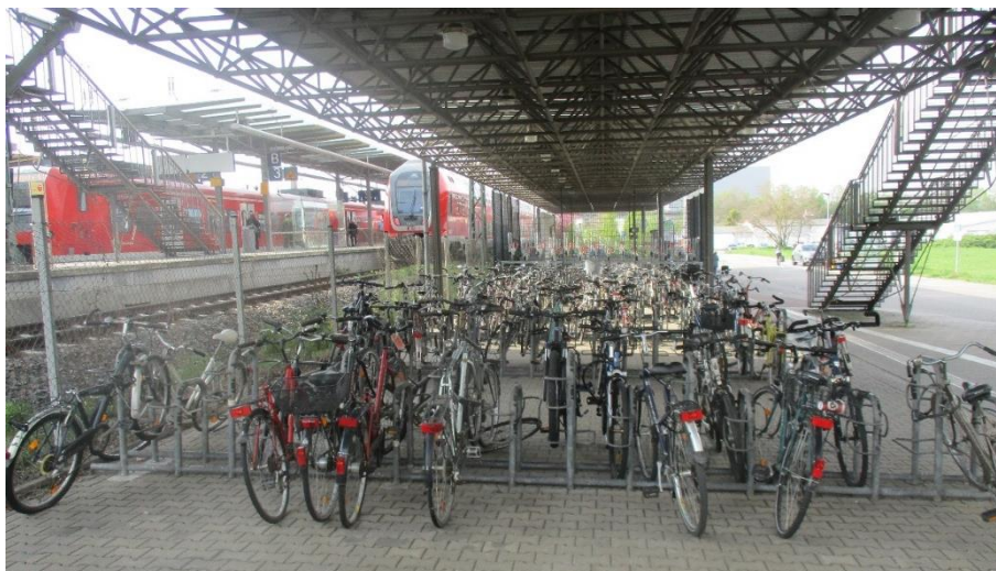
Abbildung 50: Überdachte Radabstellanlagen Bahnhof Westseite (eigenes Foto (VAR+, 2021))
